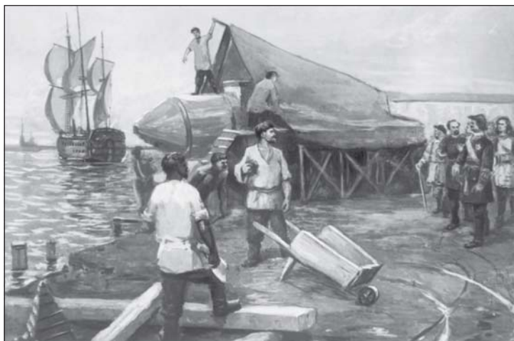
Строительство «потаенного судна» Е. П. Никонова на Галерном дворе в Петербурге. С рисунка художника Ю. Иванова
